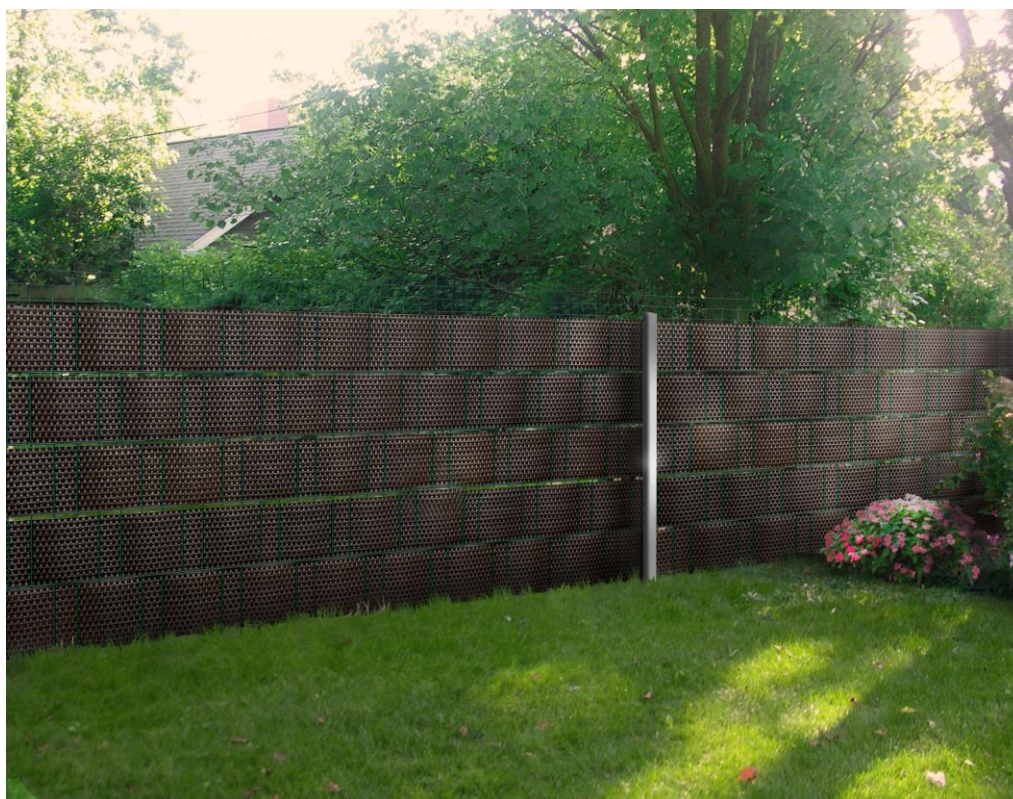
Fotografia 5 widok ogrodzenia panelowego wypełnionego matami ogrodzeniowymi
