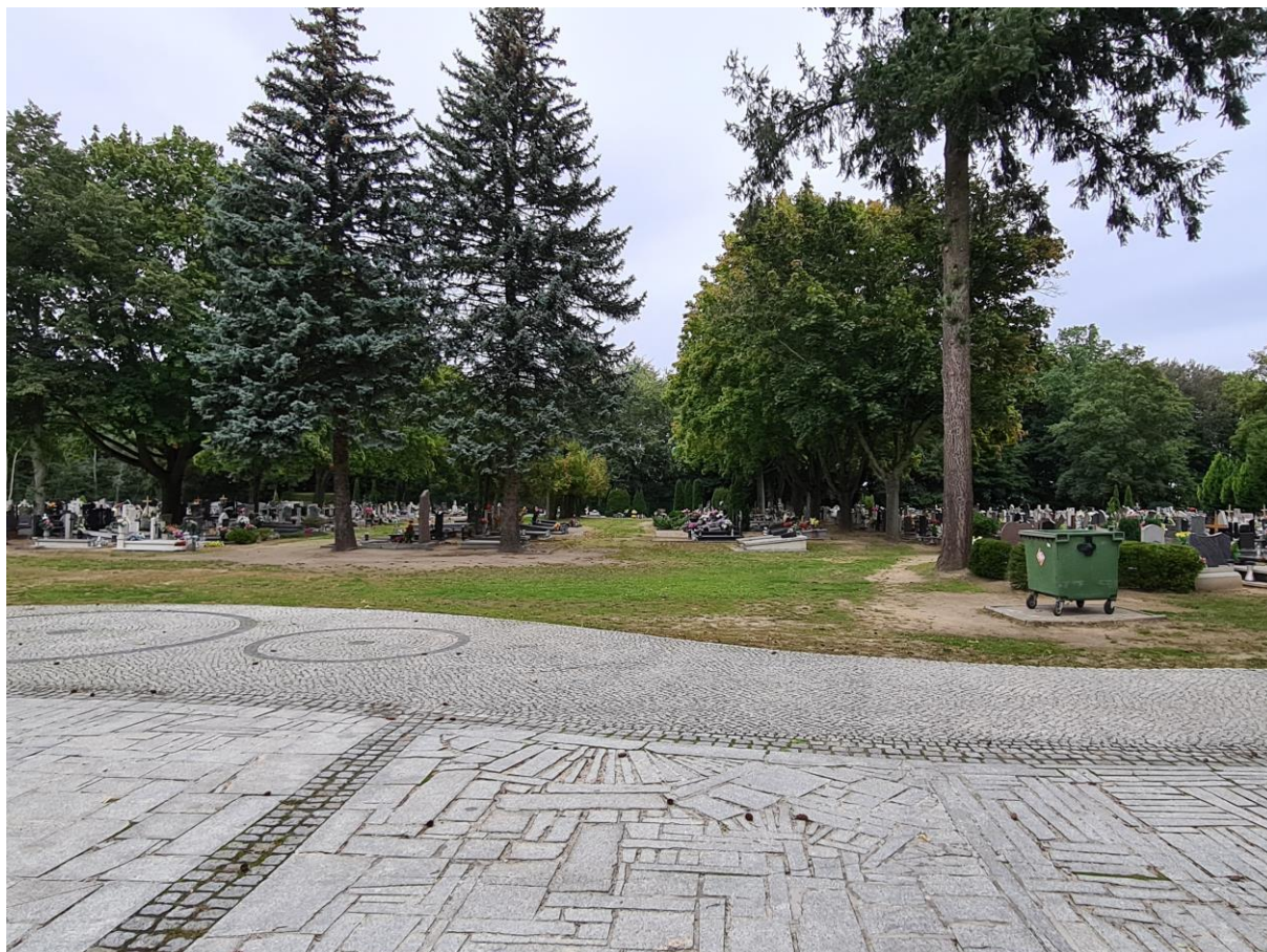
Fotografia 1 Widok na teren przed domem przedpogrzebowym – istniejąca nawierzchnia z granitową ścieżką przecinającą plac przed budynkiem.
